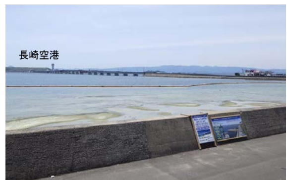
図 4 大村市森園地先に再生砂を覆砂して造成した浅場。写真は工事終了直前の2016年5月の様子。
