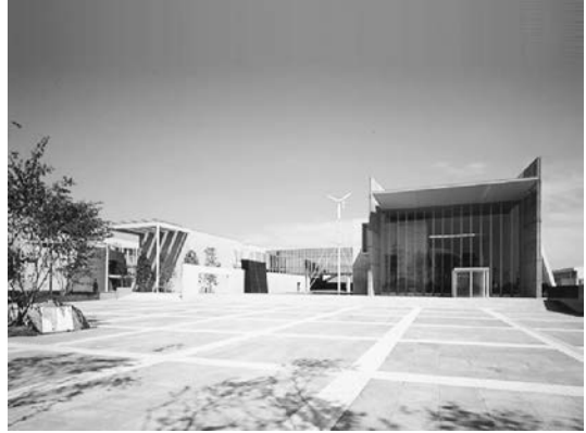
埼玉県環境科学国際センター
