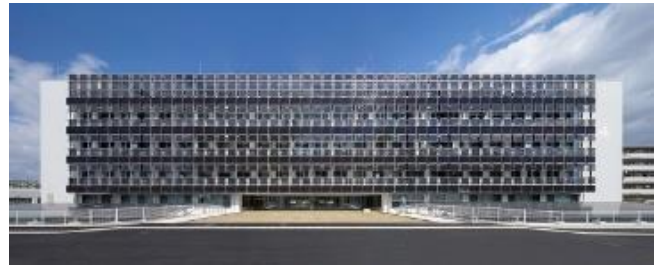
愛知県環境調査センター外観図 (建物南側前面に太陽光パネルを設置)
