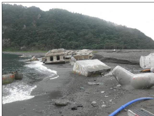
図5 小本海岸は砂浜が洗掘されていた（2011年7月）
