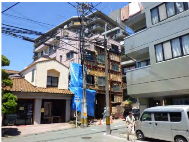
写真2 被災建築物（対策前）
