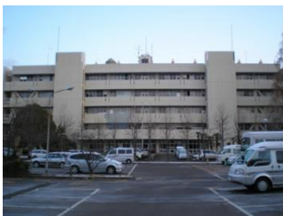
被災した本庁舎 (平成23年3月)
