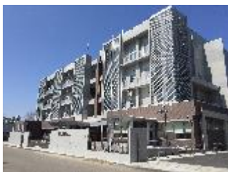
再建した本庁舎 (平成27年3月)
